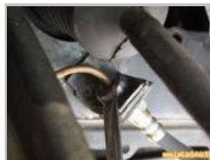
Démontage à la clef à tuyauter
